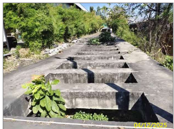
ระบบระบายน้ำและบ่อหน่วงน้ำด้วยท่อระบายน้ำบ่อกักน้ำ คสล. (Manhole)
