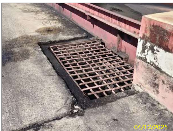
ระบบระบายน้ำและบ่อหน่วงน้ำด้วยท่อระบายน้ำบ่อกักน้ำ คสล. (Manhole)
